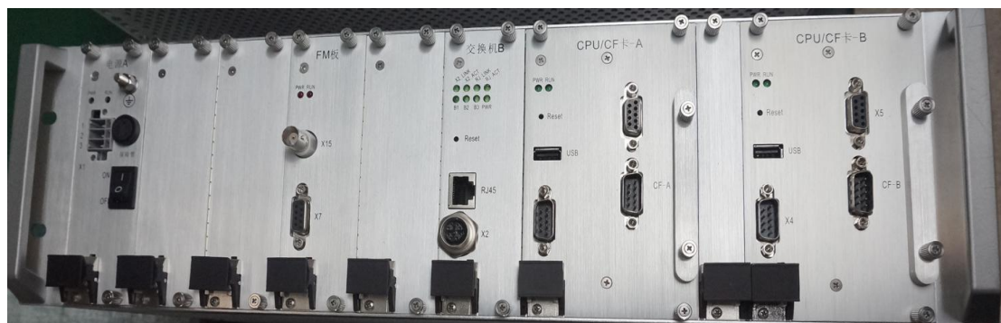
控制器安装于 5 号车乘务员室 PIS 系统柜：
